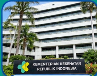
Gedung Kementerian Kesehatan
