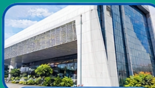
Gedung Hanggar PT GMF Aa Bandara Soekarno Hatta
